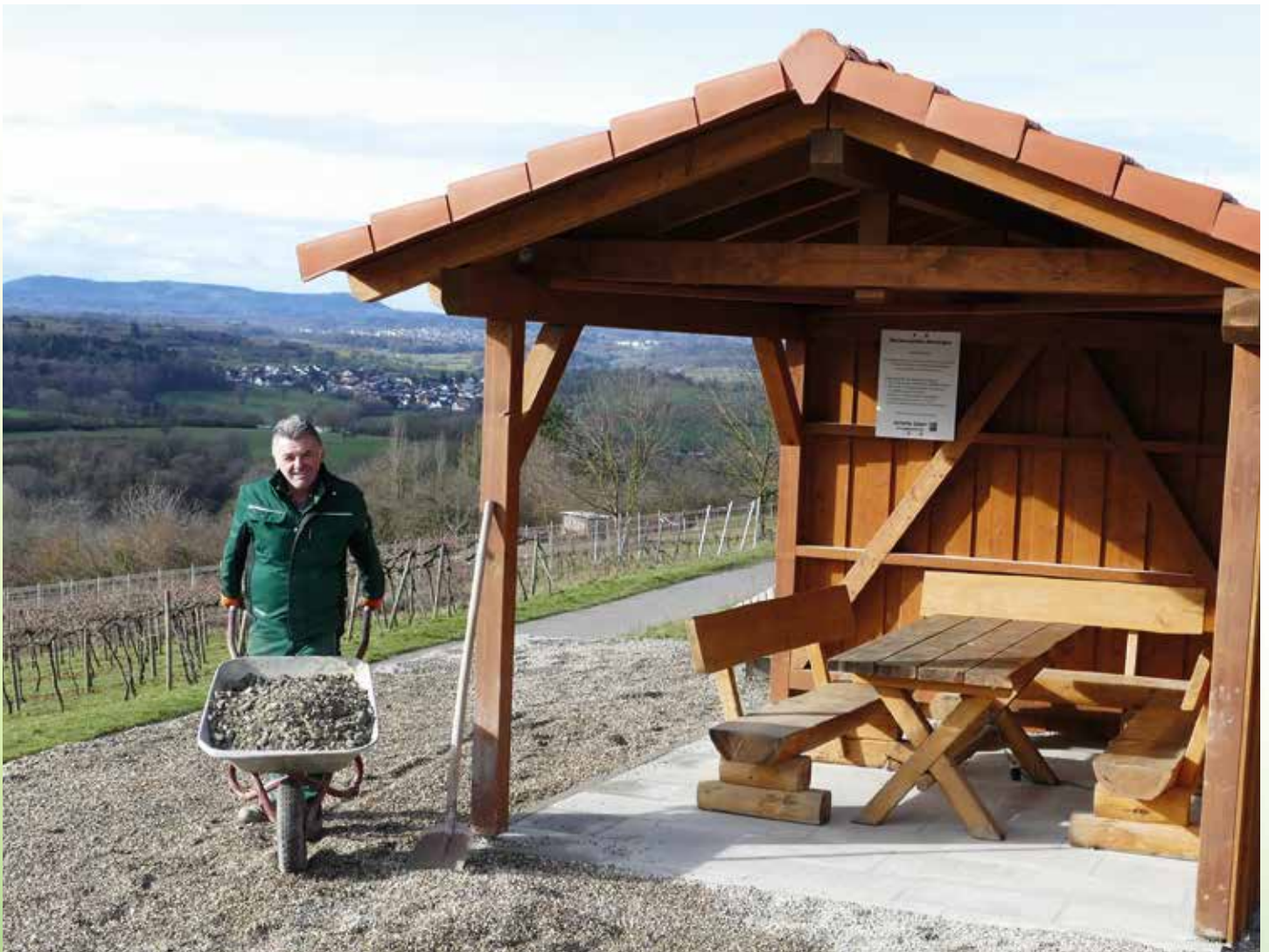
Frank Bischoff, Mitarbeiter des Gemeindebauhofes, bei den letzten Arbeiten an der Weinberghütte.
