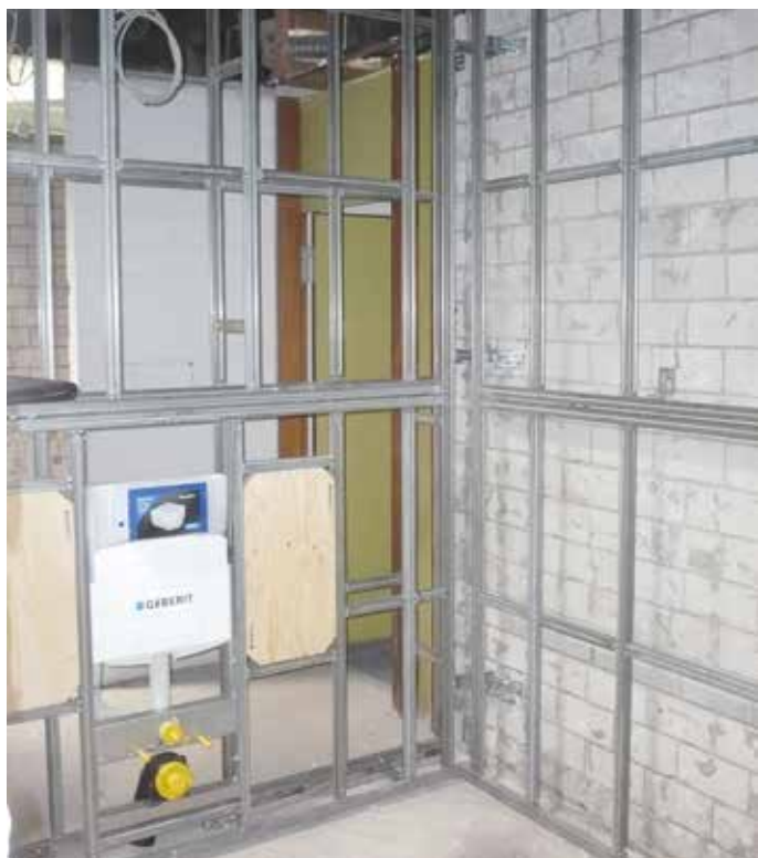
Blick in die sanitären Anlagen der Speiterlinghalle.
